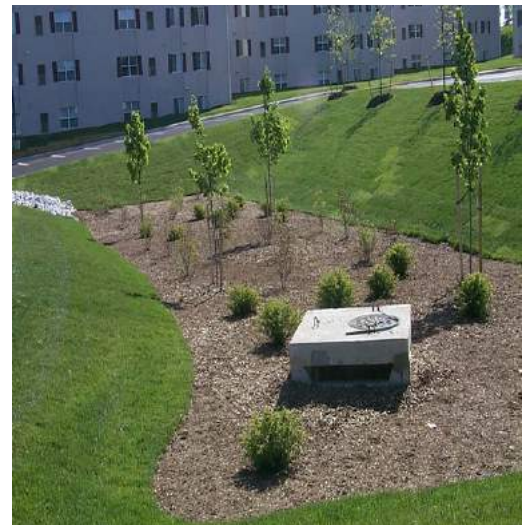
שיפור פעולת ההשהיה על ידי מתקן איסוף מים ממפלס מוגבה, והובלתם למערכת החדרה/או למערכת הניקוז העירונית.
