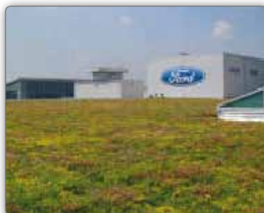
גג מפעל פורד בדירבון מינסוטה; תכנון ע"י וליאם מקדונהיו ומערכת צומח אקסטנסיבית על גג המפעל
